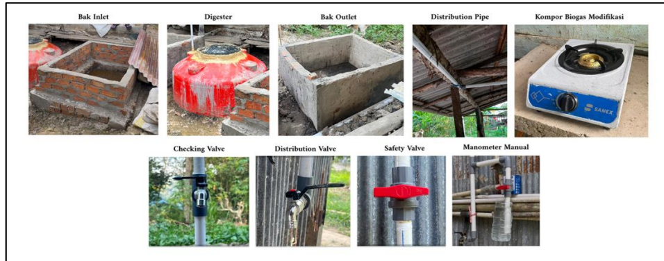
Gambar 2. Komponen Utama Instalasi Biogas
